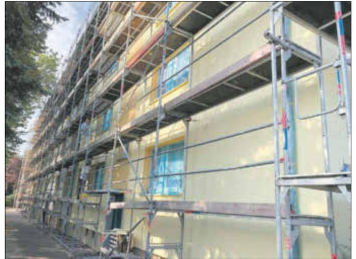
An den drei Wohnblöcken werden derzeit moderne Balkonanlagen angebaut und die Fassadenanstriche überarbeitet. Des Weiteren werden alle leerstehenden Wohnungen komplett saniert und in einigen Aufgängen wird eine Strangsanierung vorgenommen. Zum Abschluss wird eine Feuerwehrezufahrt in der Lessingstraße neu hergestellt.
